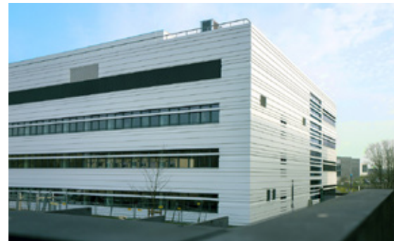
In rund zweieinhalb Jahren Bauzeit ist das Gebäude am Gesundheitscampus errichtet worden.
